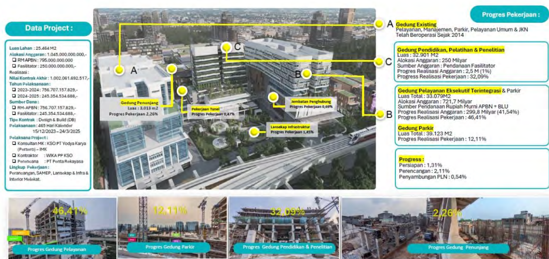
Gambar 7 Progress Pekerjaan Pembangunan Gedung RESPON-INN (per September 2024)
